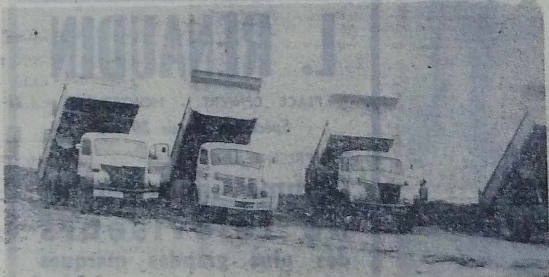
Quelques-uns des huit camions de l'entreprise Bonato occupés à déverser le remblai
