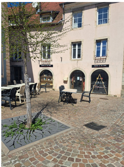
Cellule commerciale – 30, grande rue 90100 DELLE
